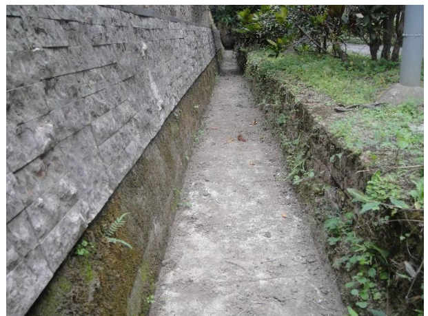
水溝清理後情形
